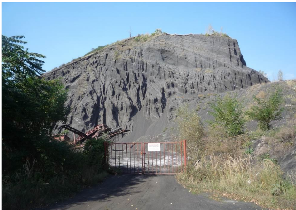
Obr. 1: Pohled na haldu v Oslavanech
