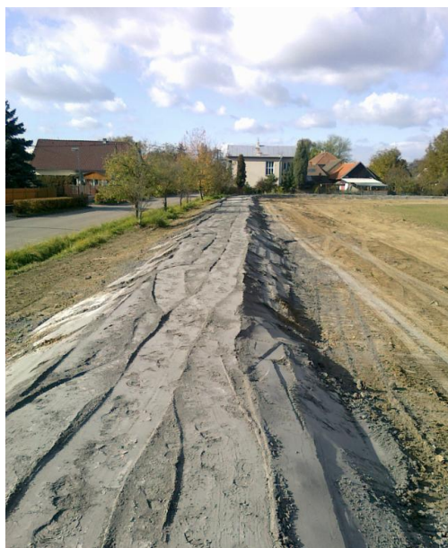
Obr. 5: Vrdy - výstavba ochranné hráze s využitím VEP (foto Elektrárna Opatovice, 2014).
