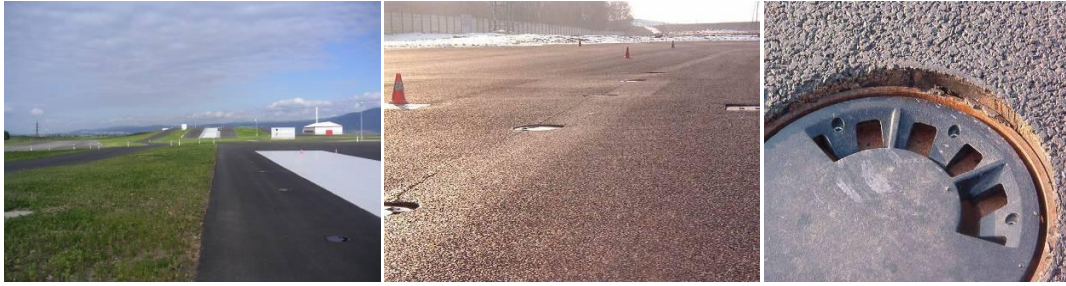
Obr. 1: Polygon most - zdvih povrchu vozovky vzhledem k odvodňovacím prvkům
