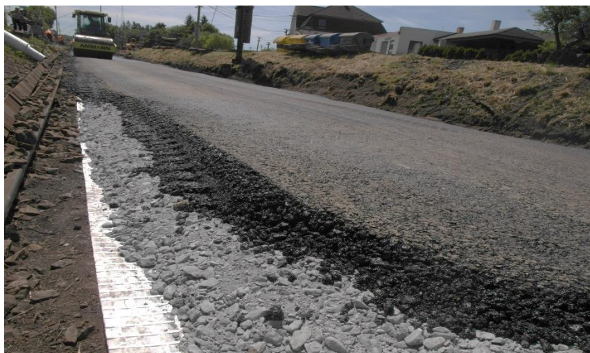
Obr. 3 – Celkový pohled na složení konstrukčních vrstev pražcového podloží (po zhutnění) ve zkušebním úseku s horní vrstvou z asfaltové směsi s obsahem 70 % R-materiálu
