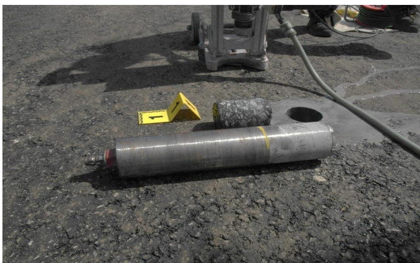
Obr. 4 – Odběr zkušebních těles metodou jádrových vývrtů s vodním výplachem
