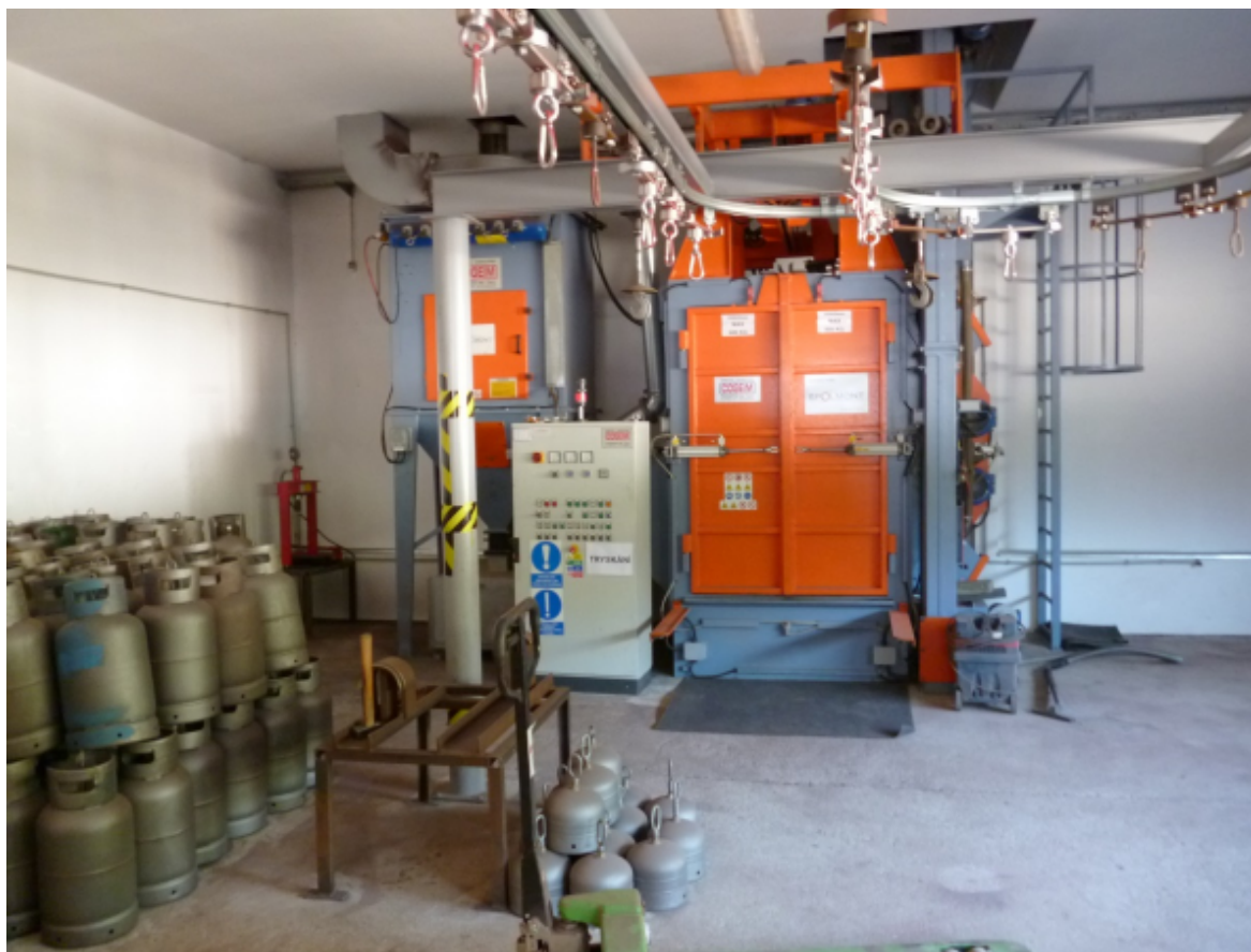
Obr 4 – Pohled na technologii tryskání
