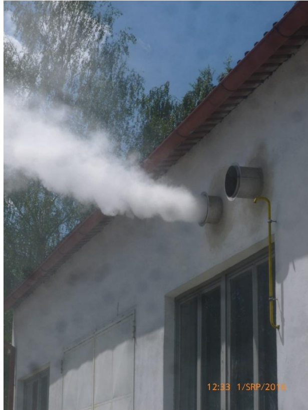
Obrázek 6: vypouštění odplynu z výrobní technologie po průchodu absorpční kolonou. Odplyn obsahuje jemné pevné částice, které plněná skrápěná kolona nedokáže zachytit.
