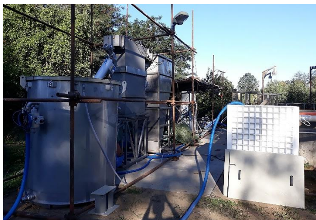
Obr. 1: Umístění poloprovozní jednotky na testovací lokalitě
