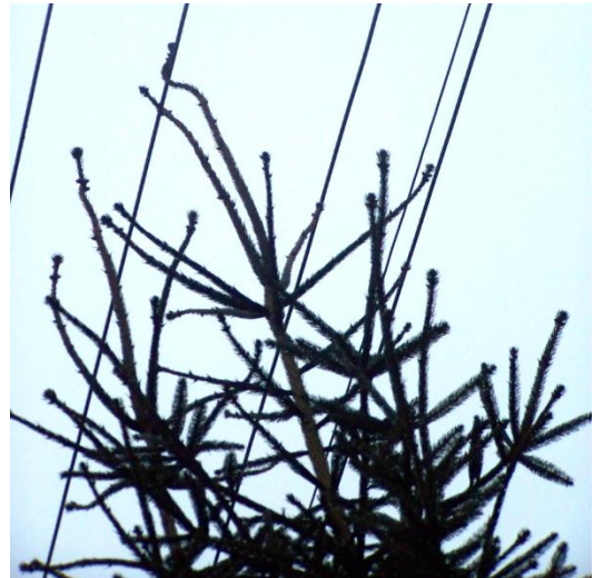
Obr. 18: Smrk zasahující do vedení NN
