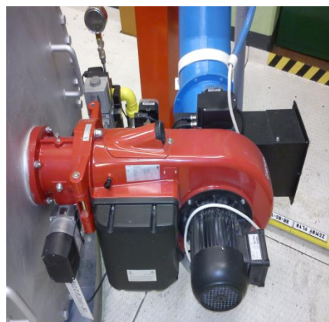
Obr.3 Pec a dopařovacia komora s horákom spařovacieho zariadenia
