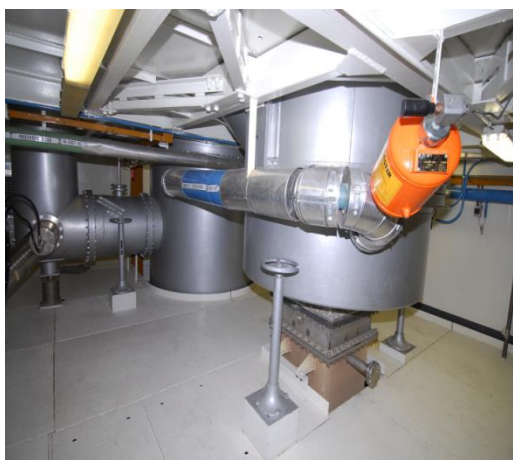
Obr.3 Pec a dopařovacia komora s horákom spařovacieho zariadenia
