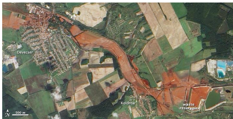
Obr. 2: Následky havárie odkaliště v Aika-Kolontár (Zdroj: UNECE)
