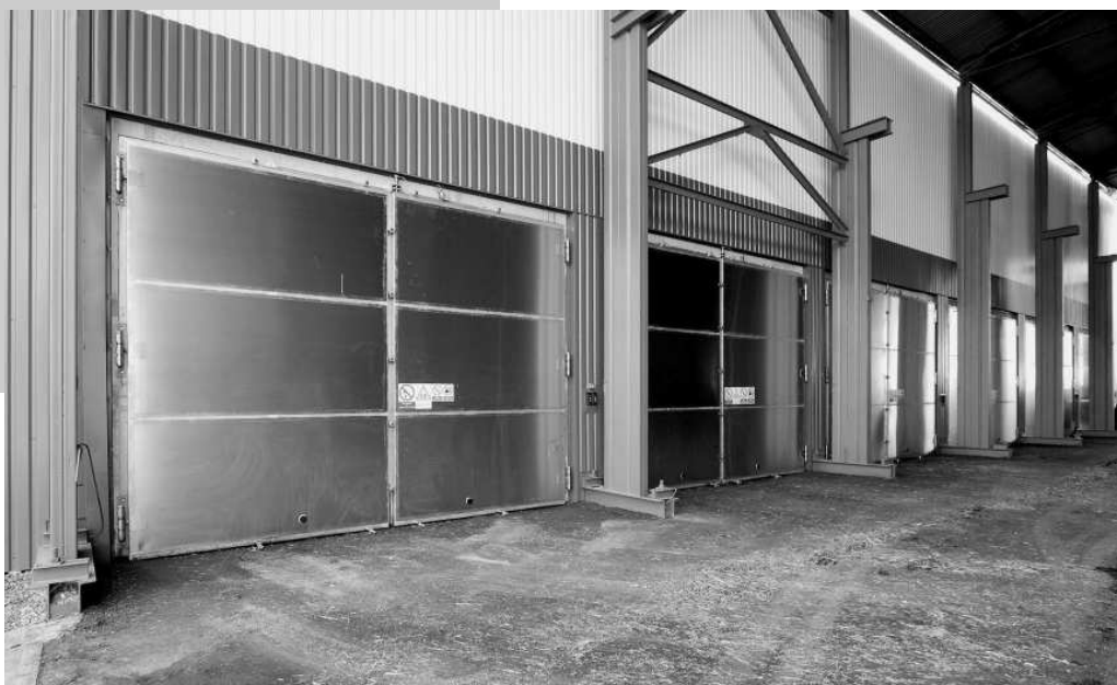
Obrázek: Bioplynová stanice Šumperk-Temenice – vrata fermentorů a čelní pohled
