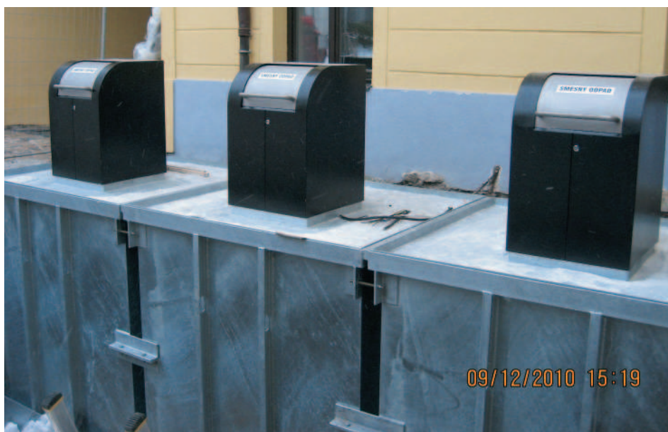
Montáž prvního zařízení v Plisku - prosinec 2010
