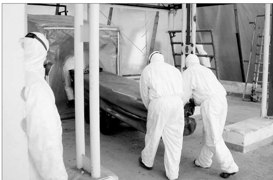
Obrázek 1: Materiál obsahující azbest odstraňují v kontrolovaném pásmu pracovníci vybavení osobními ochrannými pomůckami.
