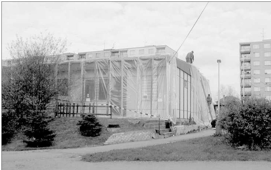
Obrázek 2: Vytváření kontrolovaného pásma před likvidací azbestového nebezpečí v objektu
