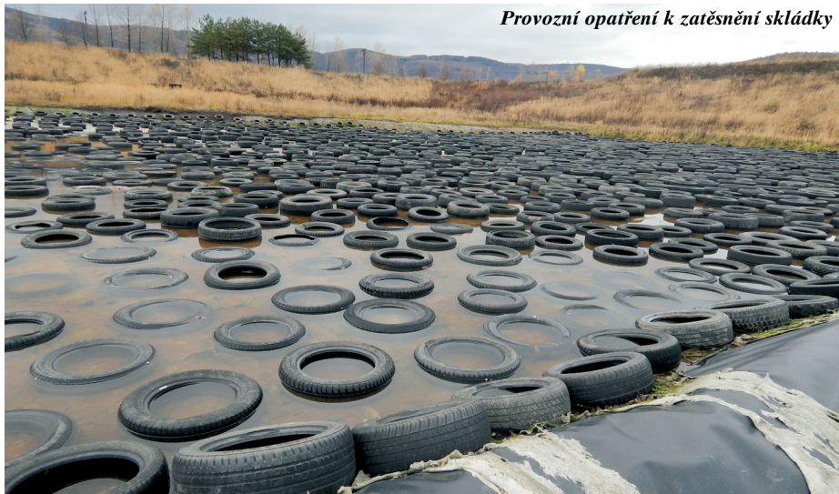
Provozní opatření k zatěsnění skládky
