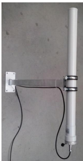
Obrázek 15 Upevnění sondy na konzole
