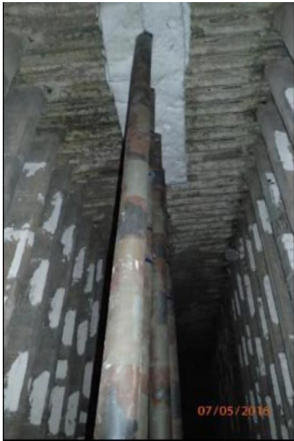
Obr. 3 Průchod smyčky přes strop
