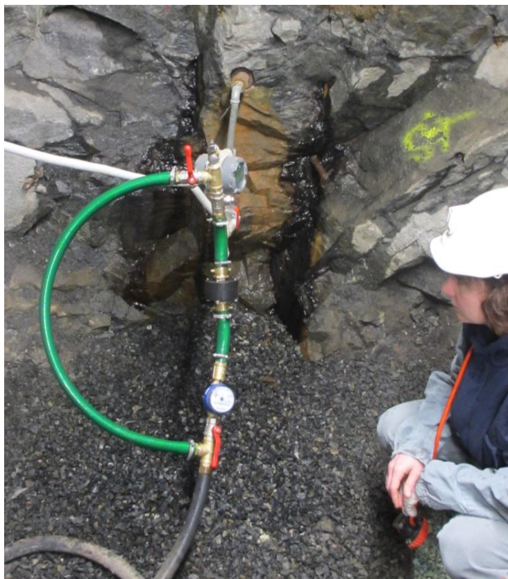
Obr. 5 – Instalace vzorkovače na výstup z průzkumného vrtu
