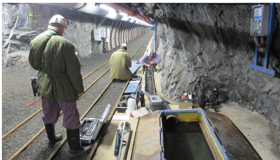
Obr. 4 – Měření odtoku důlních vod z PVP Bukov
