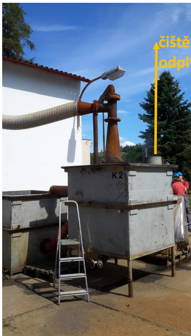
Obrázek 9: výstup odplynu do okolního vzduchu po průchodu ejektorem, kterým byl zachycen dým tvořený jemnými pevnými částicemi.
