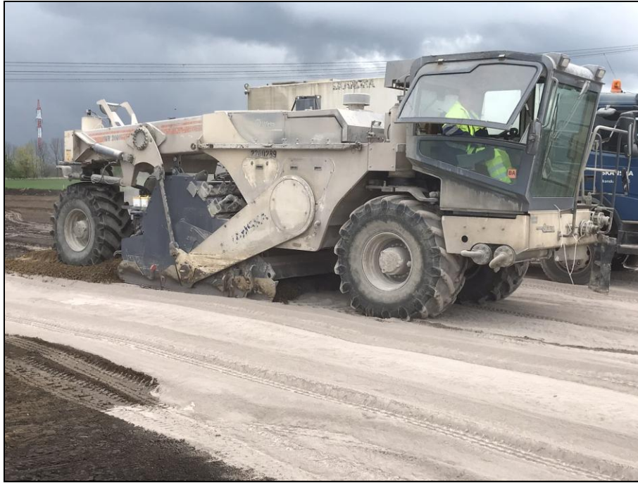
Obrázek 10 Mísení fluidních popílků z Teplárny Kladno zemní frézou v množství 2% se zeminou při zhutňovací zkoušce na stavbě D49 Hulín – Fryšták se zeminami dne 25.4.2022
