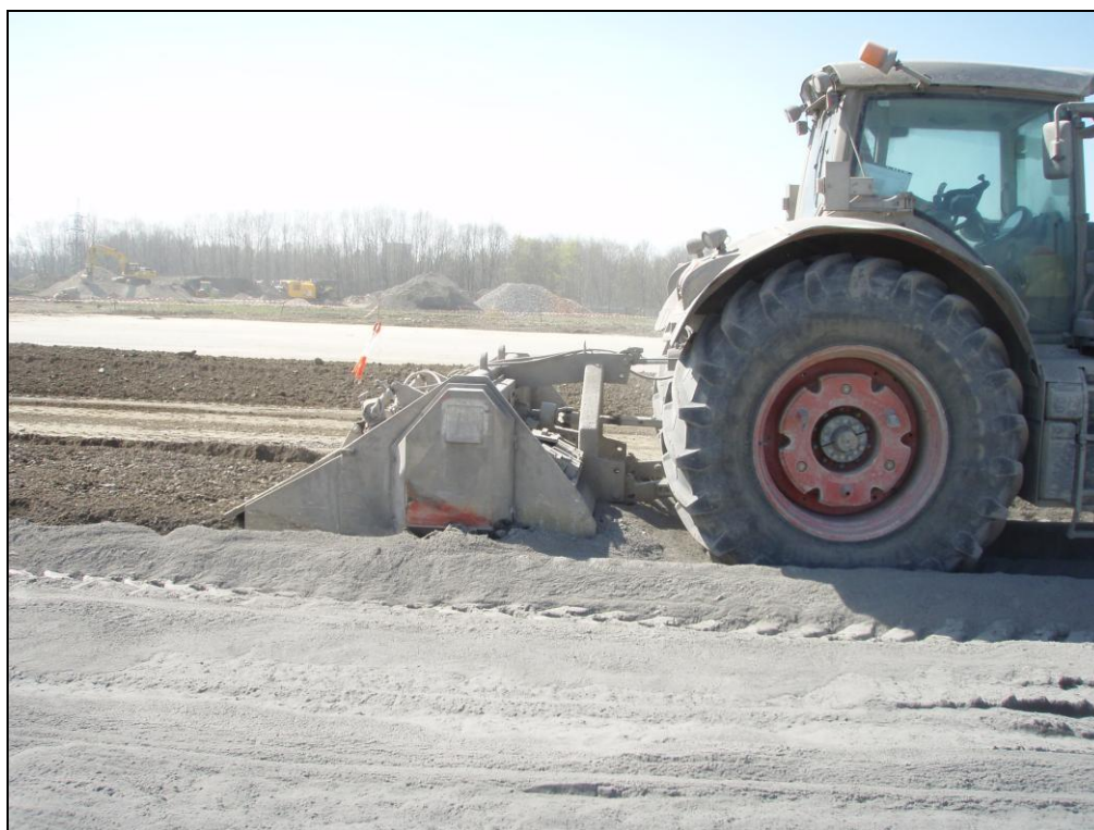
Obrázek 3 Úprava zemin pojivem RSS na bázi vápenatých popílků, Havířov – Globus (2011)
