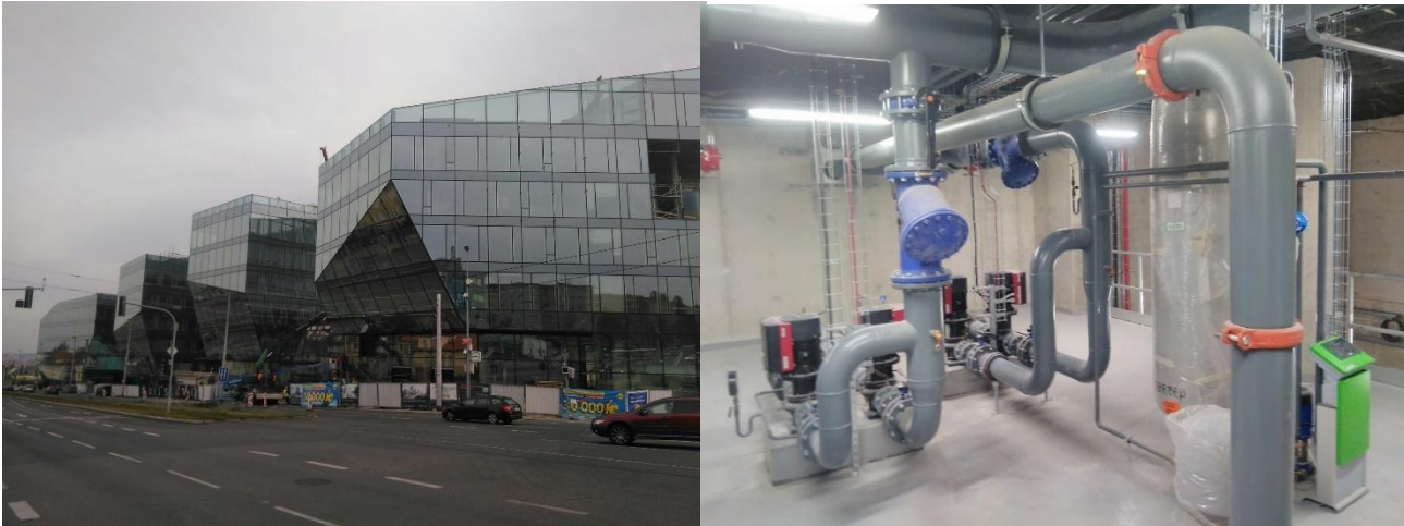
Obr. 1: Příklad stavebního objektu naplněného 50 tis. l nemrznoucí směsí (Bořislavka - Praha 6).
