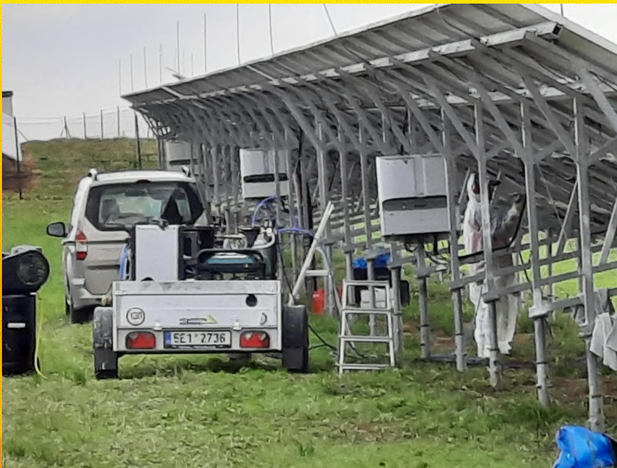
Renovace PV panelů v polních podmínkách
