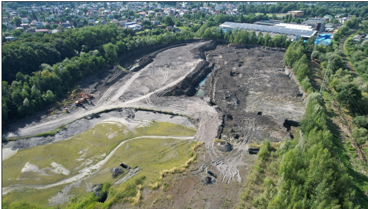
Letecký snímek odkaliště Elektrárny Třebovice
