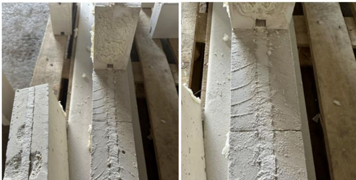
Obr. 5: Demontáž sádrové stěny, PU pěna ve styčných spárách.
