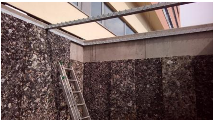
Obr.33 Exteriérové odhlučnenie technológie
