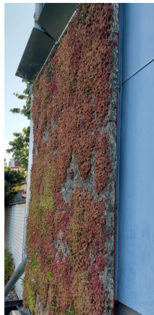
Obr.27 Realizácia chladiacej fasády STERED
