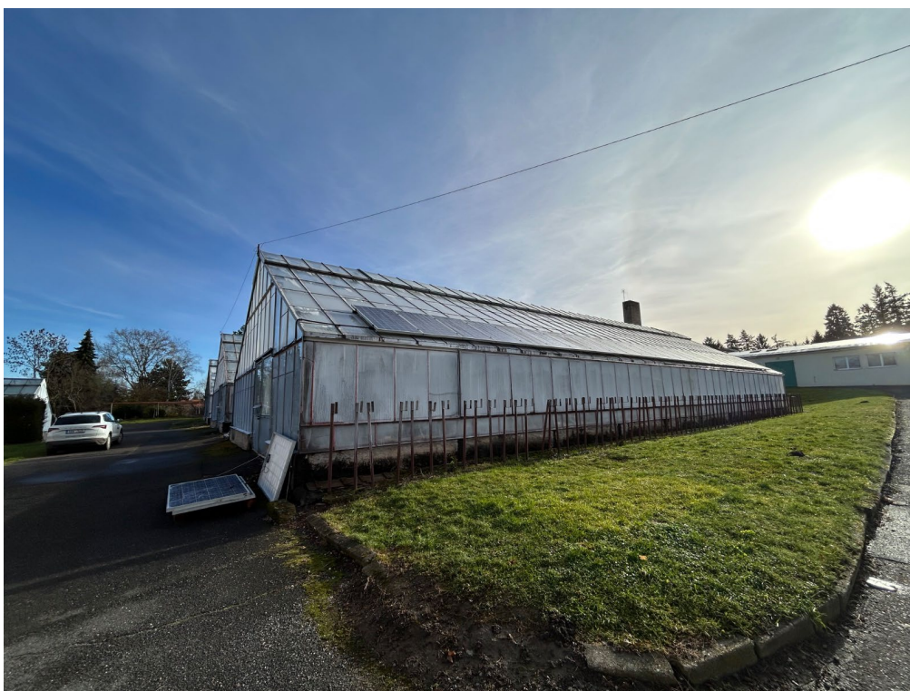
Obrázek 2: Instalace reuse PV modulů na skleníku v areálu VÚKOZ
