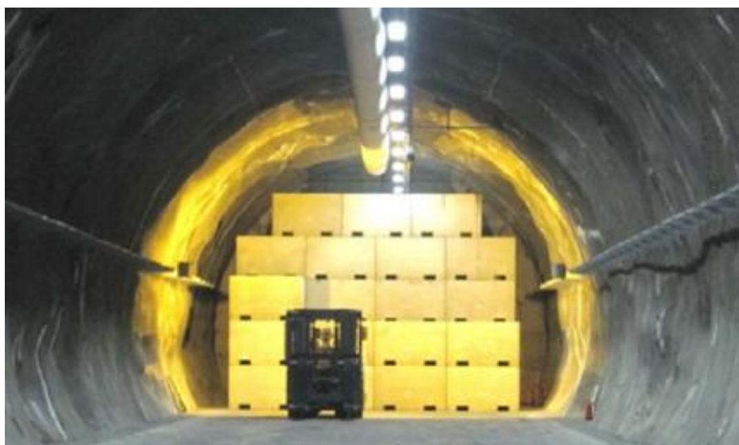
Obr. 15: Stohování úložných kontejnerů v úložišti Bátaapáti (PURAM)
