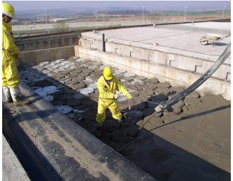
Obr. 4: Betonáž ocelových sudů v úložném prostoru (ANDRA) (SURAO)
