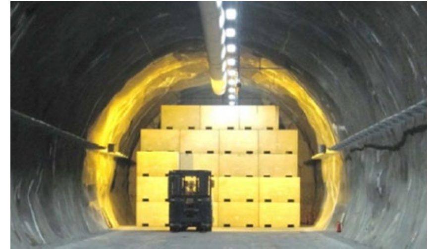
▲ Stohování úložných kontejnerů v úložišti Bataapáti (PURAM)
