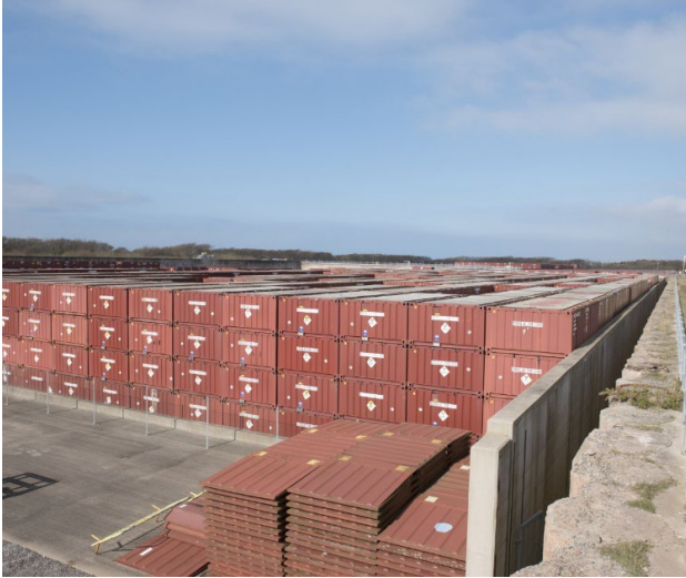
▲ Umístění odpadu do ISO kontejnerů v úložišti Drigg (NDA)
