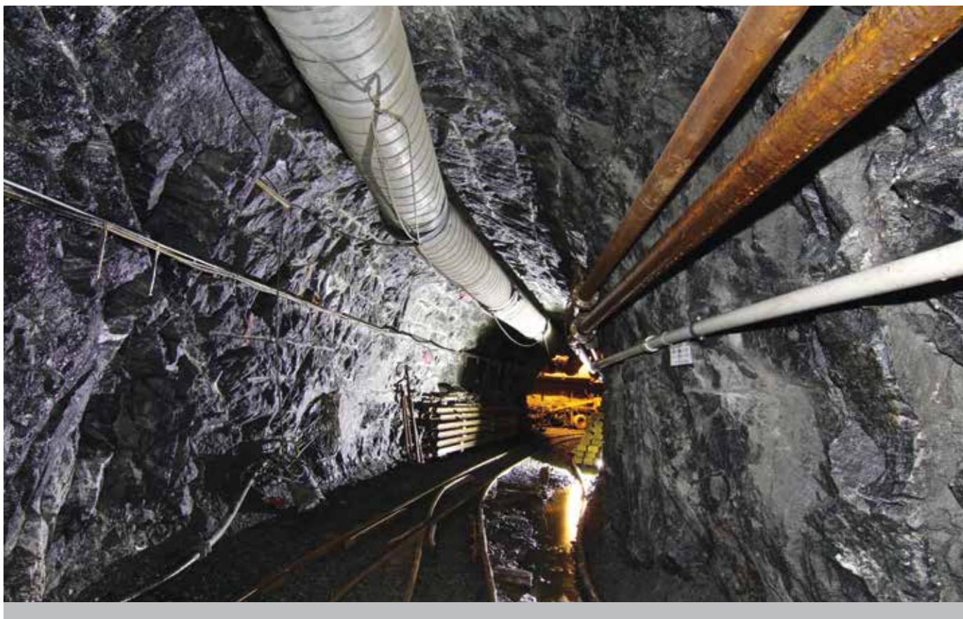
Podzemní výzkumné pracoviště Bukov, výstavba experimentální rozrážky.
