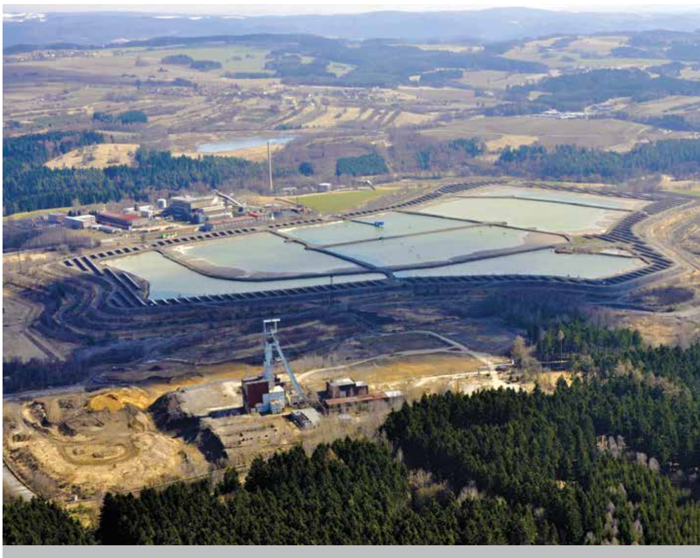
Letecký pohled na odkaliště K1.
